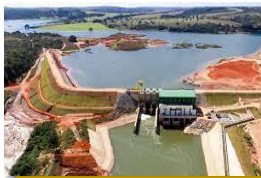
Figura 2- Pequena Central Hidrelétrica (PCH)
