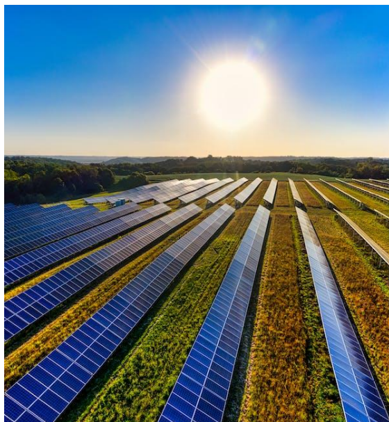
Figura 6- Usina Fotovoltaica (UFV)
