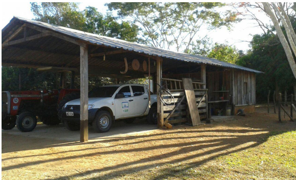
Figura 15. Galpão em madeira com dois cômodos para guardar equipamentos e alojamento.
