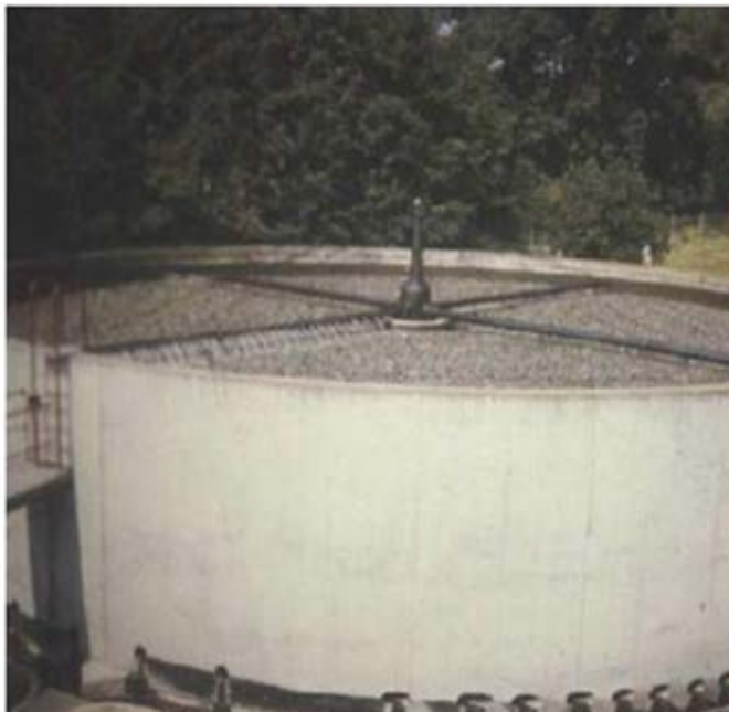
Figura 9 – Filtro biológico percolador 2
