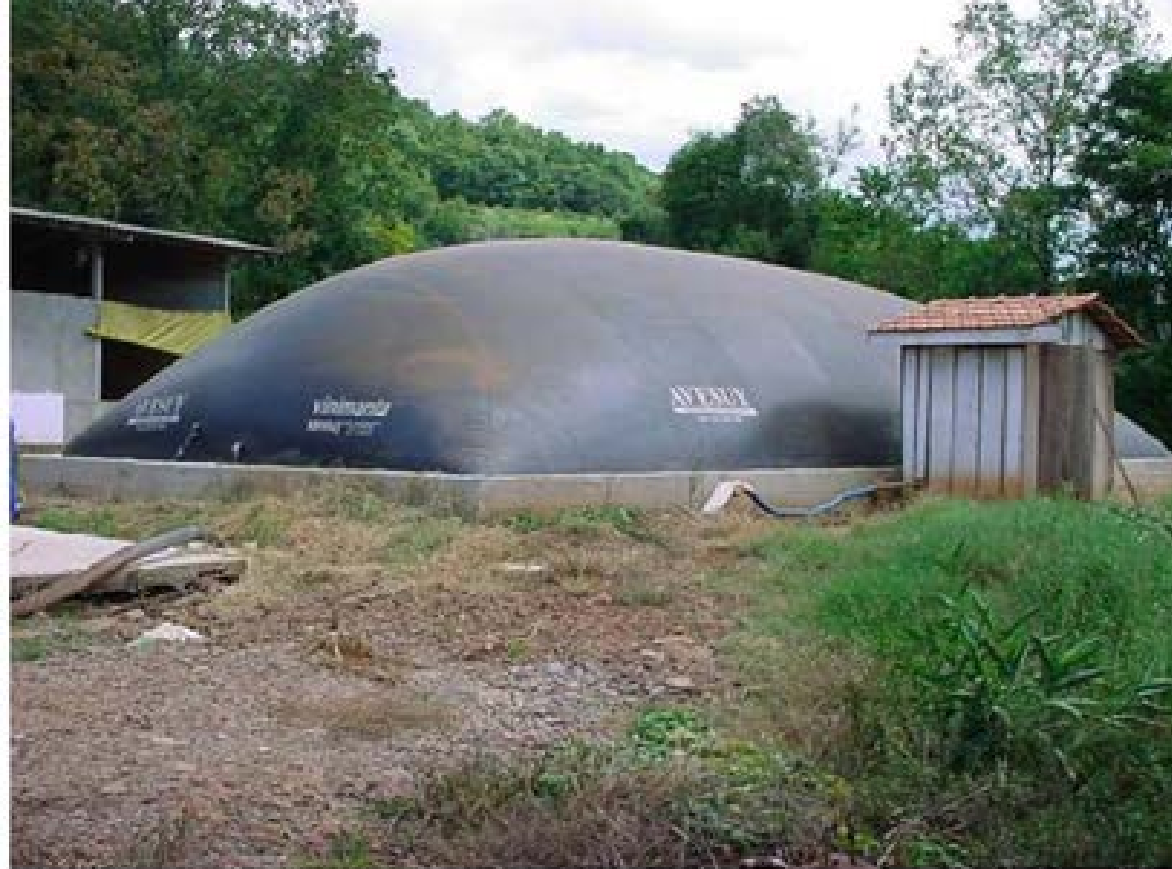
Figura 11 – Biodigestor de vinil
