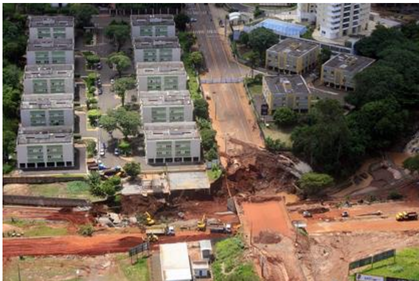
Foto 36– Danos causados pelas chuvas em Campo Grande em fevereiro de 2010.
