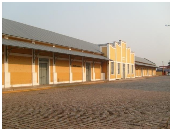
Foto 14 - Estação Ferroviária Noroeste do Brasil - Armazém Cultural em Campo Grande, MS, 2010.
