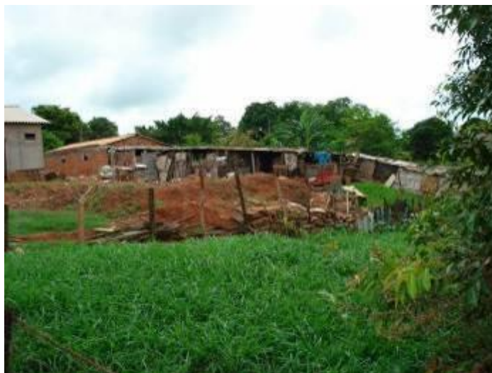
Foto 37 – Presença de barracos e construções em APP. (Bacia Sudeste).
