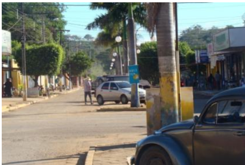
Foto 27 - Vista parcial do centro do município de Bodoquena em que apenas as depressões transversais formam o sistema de drenagem pluvial, em 01 de junho de 2010.
