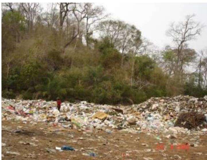
Foto 20 – Vista do lixão mostrando a presença de catadores e encosta dos morros
