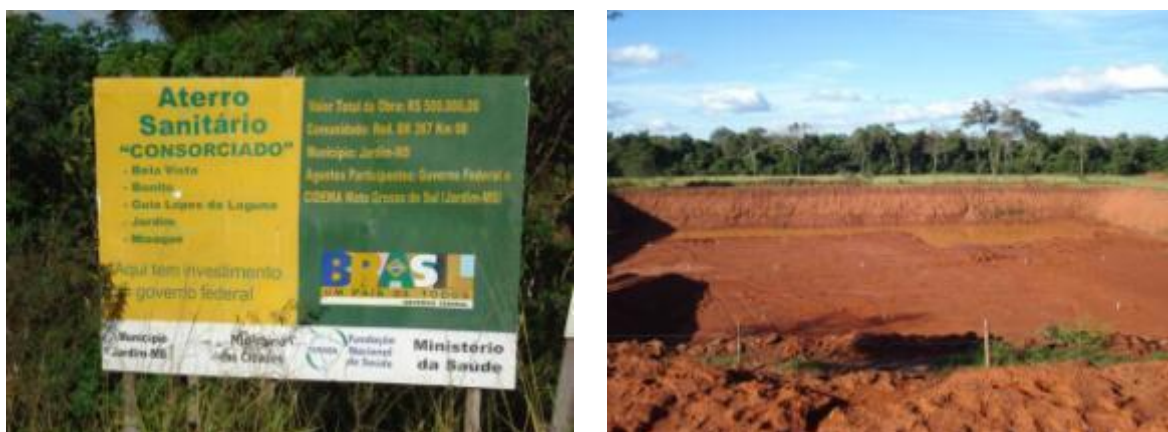
Foto 24 - Vista parcial das obras de instalação do Aterro Sanitário Consorciado.
