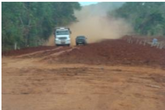
Foto 14 – Vista parcial MS-178, tráfego de veículos pelo caminho de serviço, em 02 de junho de 2010.
