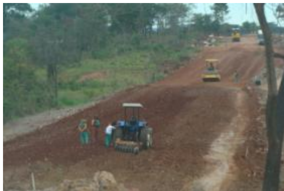
Foto 15 - Vista parcial dos serviços de terraplenagem na MS-178, em 02 de junho de 2010.
