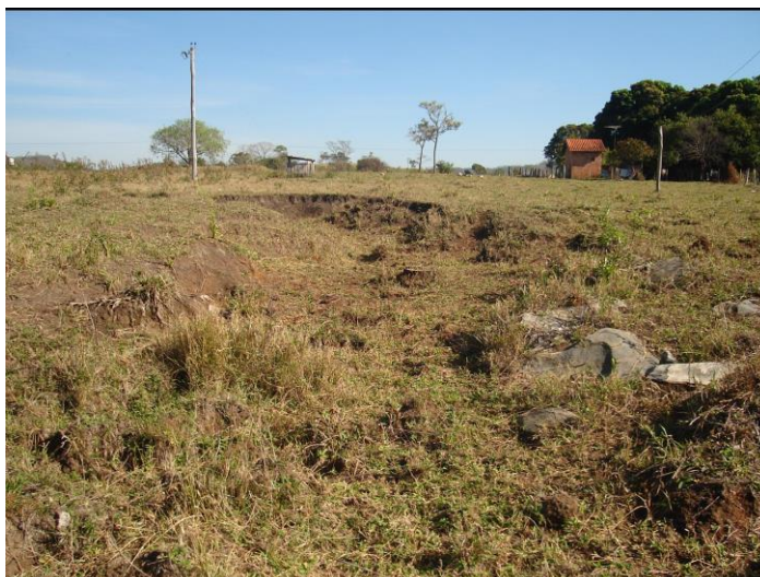
Foto 34 – Erosão na Bacia do Córrego Acampamento.
