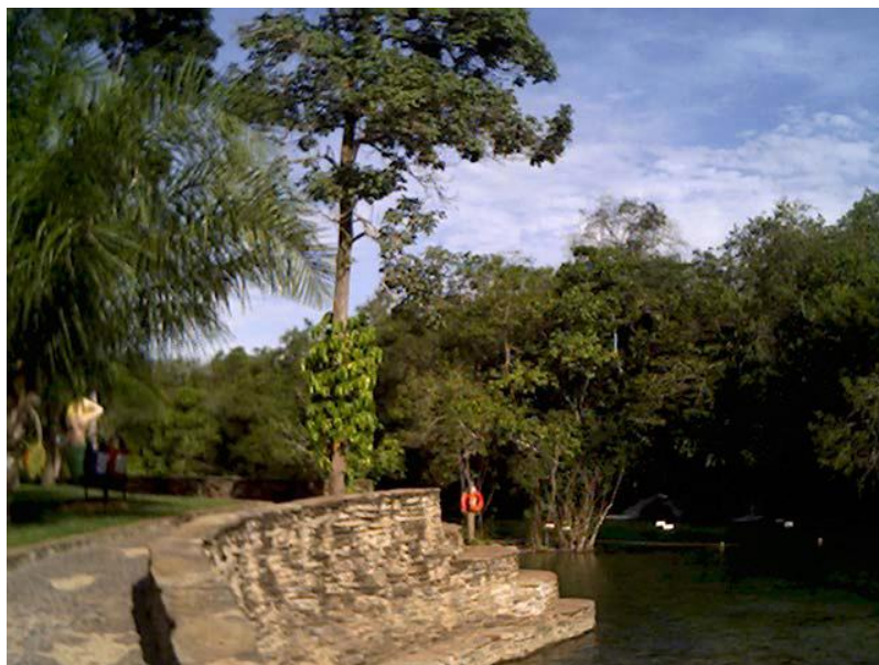
Foto 40 - Estruturas de alvenaria construídas na área de preservação permanente (muro de arrimo) do rio Formoso.
