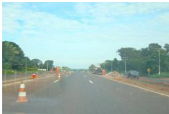
Foto 17 - Vista parcial da rodovia BR-267/MS, duplicação da travessia urbana de Guia Lopes da Laguna, em 03 de junho de 2010.
