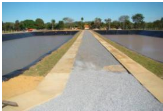
Foto 19 - Vista parcial ETE- Bodoquena (parte das lagoas de tratamento), em 01 de junho de 2010.
