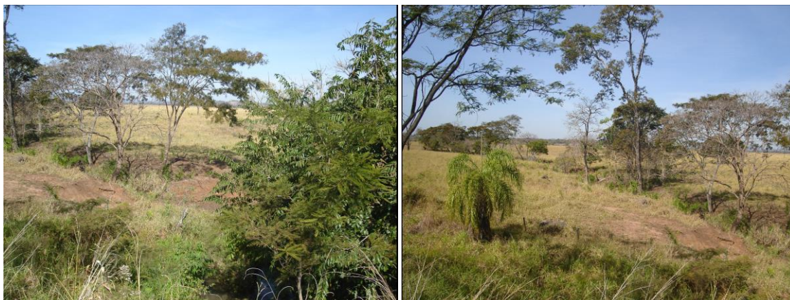
Foto 30 – Travessia do Córrego João Augusto com a rodovia, mostrando a ausência de Área de Preservação Permanente, início de processo erosivo.
