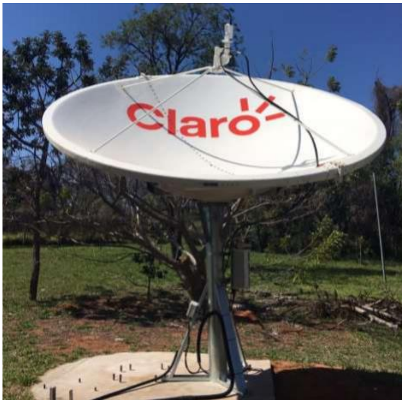
Antena digital instalada e em funcionamento
